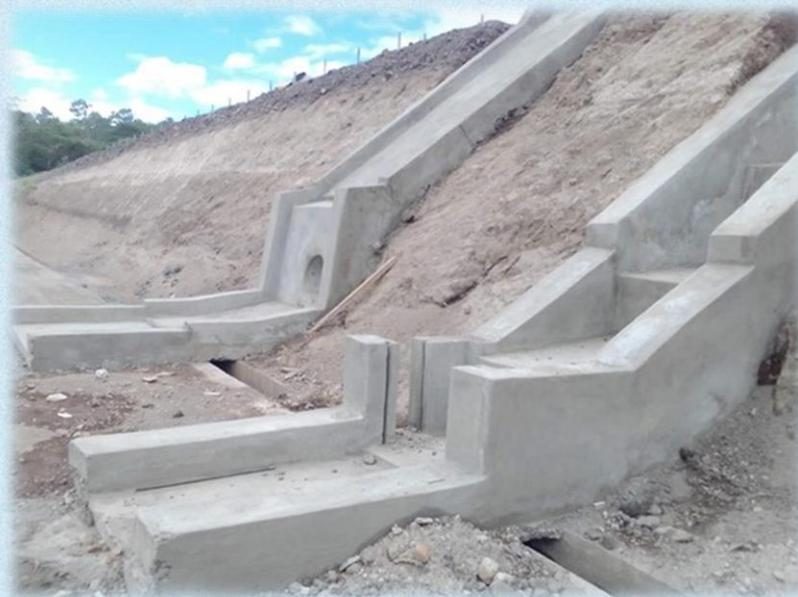
*Ilustración 4 – Obras de drenaje en Plataforma*
