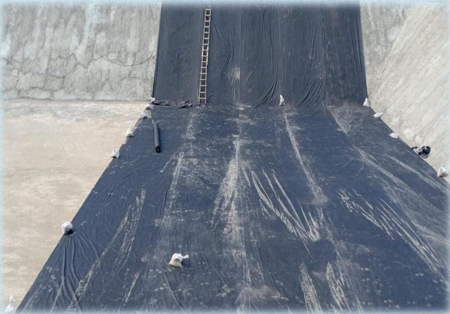
Ilustración 1. Instalación de geotextiles en pila de agua
