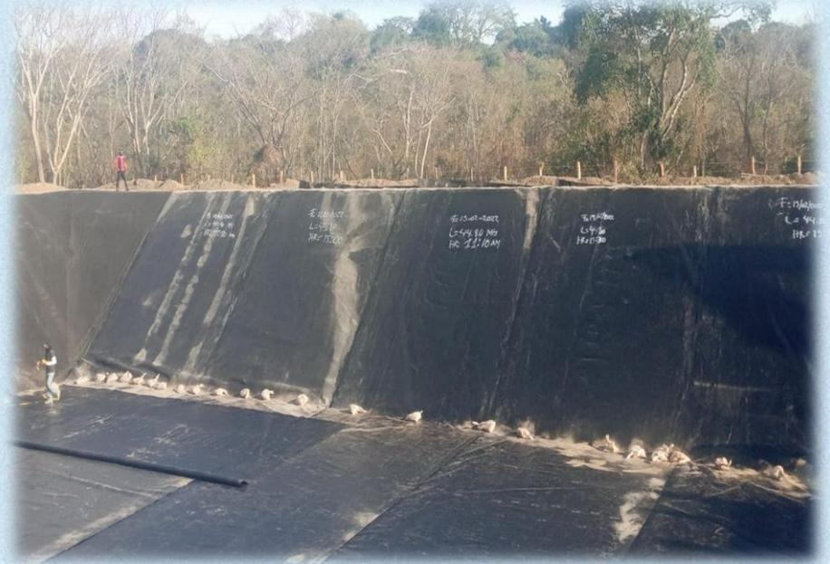
Ilustración 2. Instalación de geomembrana en pila de agua
